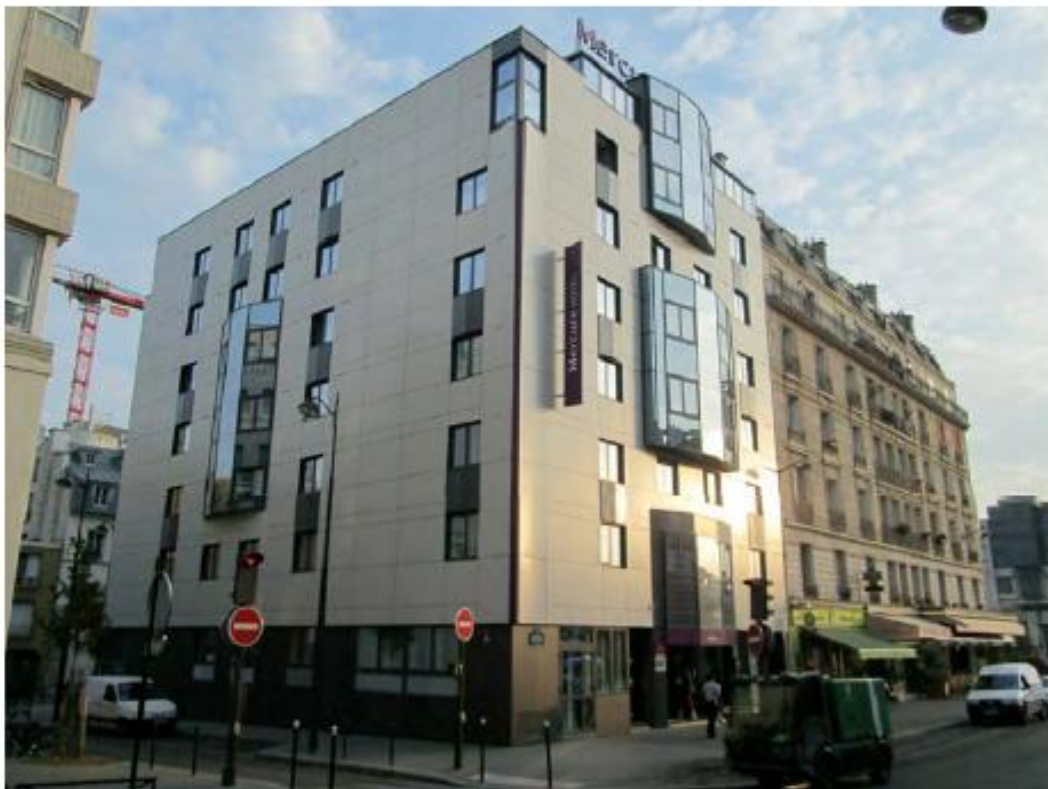
DP. 7.1. Photo de l'existant
