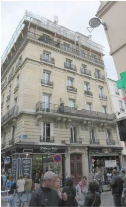
DP 7.1 - Photo de l'existant
