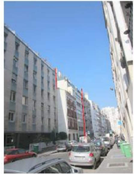
DP 8 - Photo de l'existant, vue lointaine
