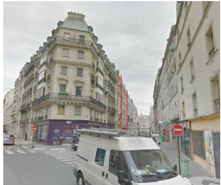
DP 8 - Photo de l'existant, vue lointaine
