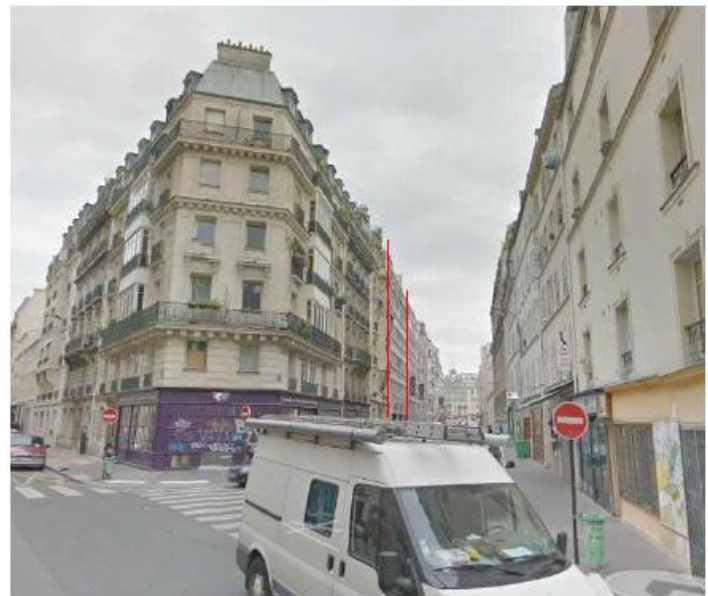
DP 8 - Photo du projet, vue lointaine (L'antenne est invisible depuis ce point de vue)
