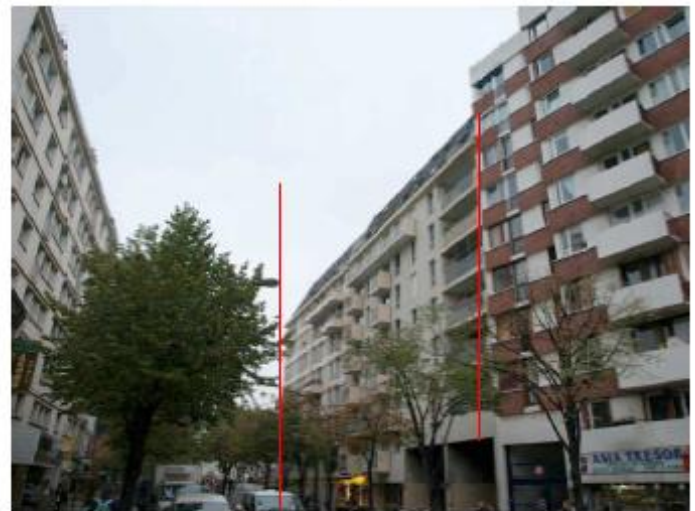
DP 8 - Photo du projet, vue lointaine (L'antenne n'est pas visible depuis ce point de vue)
