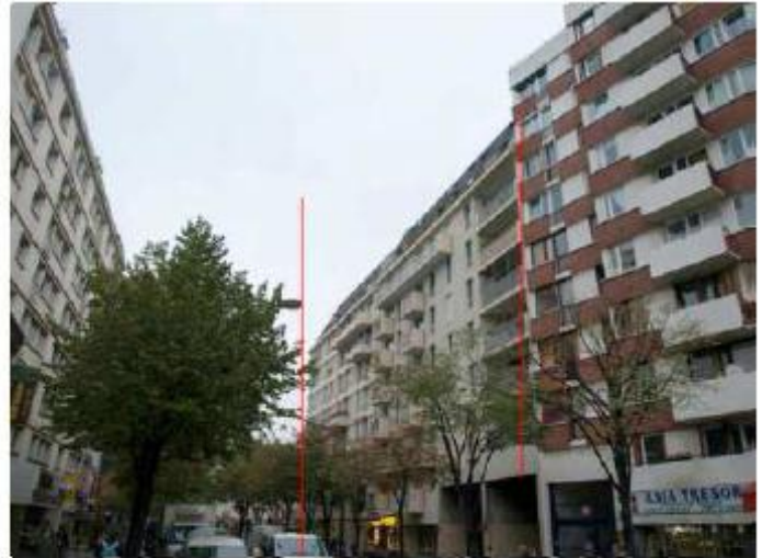
DP 8 - Photo de l'existant, vue lointaine
