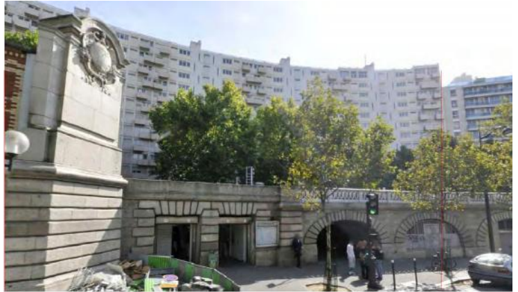
DP 8 - Photo de l'existant, vue lointaine
