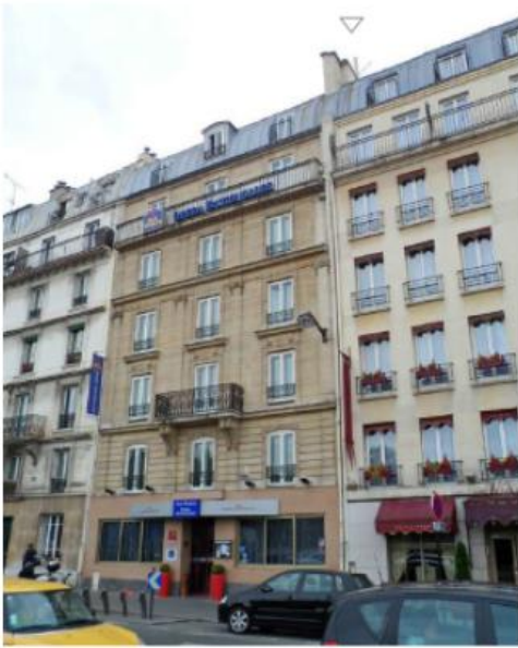
DP 7.1 - Photo de l'existant
