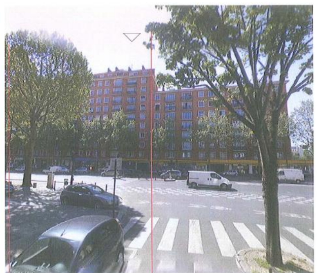
DP 8 - Photo du projet, vue lointaine
