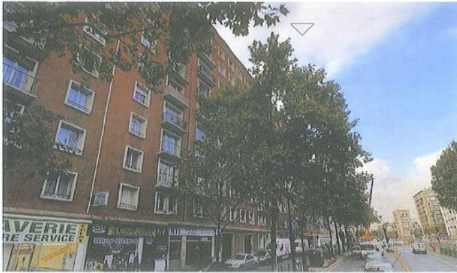
DP 7.1 & 6.1 - Photo de l'existant
