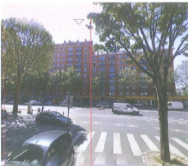
DP 8 - Photo de l'existant, vue lointaine
