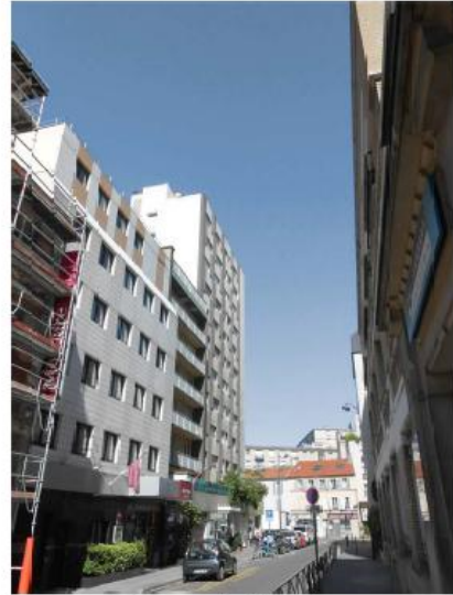
DP 8 - Photo de l'existant, vue lointaine
