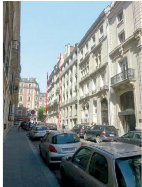
DP 8 - Photo de l'existant, vue lointaine
