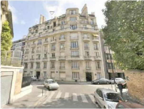
DP 7.1 - Photo de l'existant
