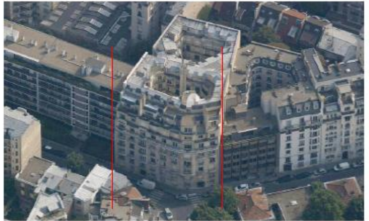
DP 8 - Photo du projet, vue lointaine
