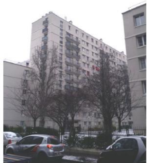
DP 8 - Photo de l'existant, vue lointaine
