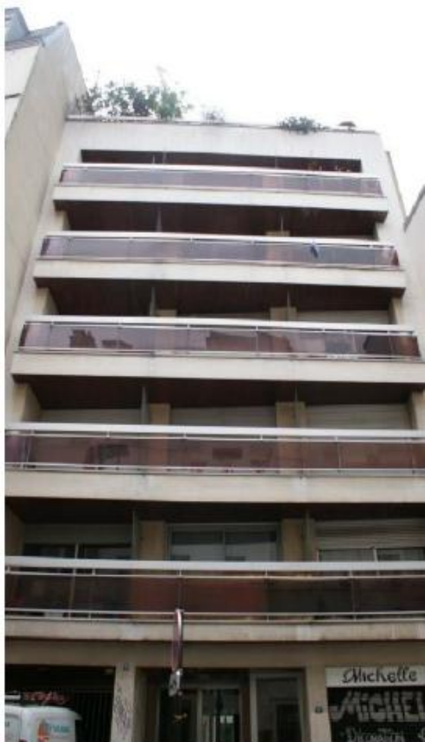
DP 7 Photo de l'existant
