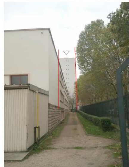
DP 8 - Photo du projet, vue lointaine
