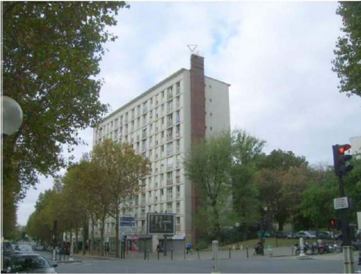
DP 7.1 - Photo de l'existant
