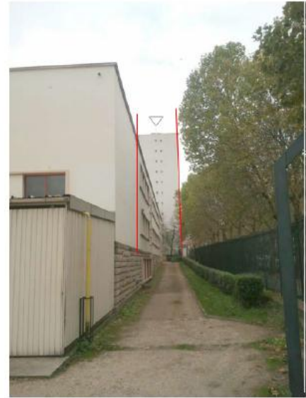
DP 8 - Photo de l'existant, vue lointaine
