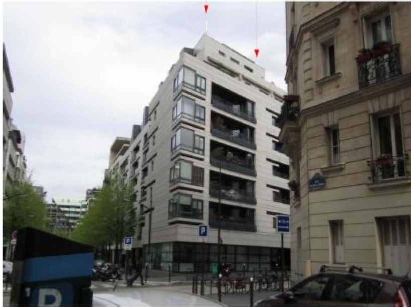
Vue façade existante :
