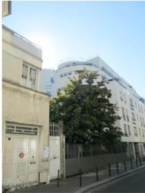
DP. 7.1. Photo de l'existant
