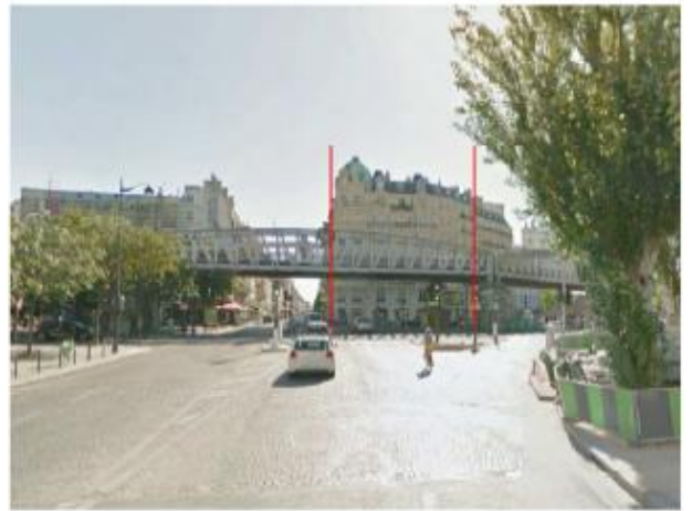
DP 8 - Photo de l'existant, vue lointaine
