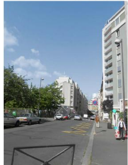
DP 8 - Photo du projet, vue lointaine
