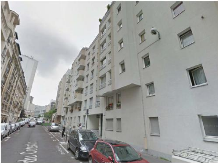
DP 7.1 - Photo de l'existant
